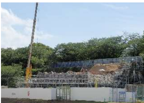
▲ 祈念櫓石垣工事の様子
