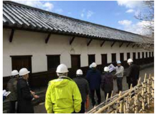
福岡城南丸多聞櫓の修理
