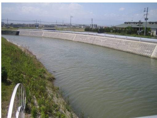
周船寺川都市基盤河川改修事業 延長約 4.6 km (河川の改修工事 2 級河川で延長 1km 以上)
