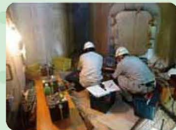
工場内煙突付近での排ガス調査の様子
